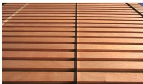
A rivestimento della parete di fondo e del soffitto, **Xilomoenia, sistema di ventilazione a scudo termico, sempre di XILO1934**, che preserva il fabbricato dall'invecchiamento, riducendone l'impatto ambientale e lo isola acusticamente, firma con i suoi elementi in legno massello, inseriti a scorrimento o a incastro su un profilo di acciaio inox, la solidità della struttura.
