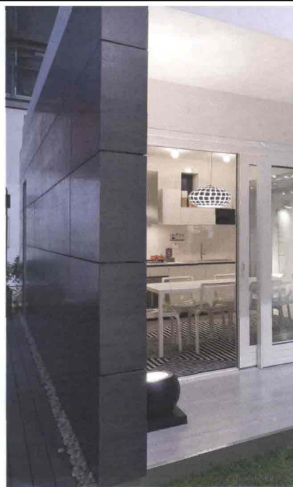
↑ Parete ventilata realizzata con Ferro Black di Ceramica Sant'Agostino / Ventilated façade made of Ferro Black by Ceramica Sant'Agostino, "Rinascimento" by Marco Piva, "Social Home Design - Abitare il Futuro", MADE Expo, Milano, 2011. Ph. Luca Casonato
