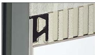
**4.9 Schlüter®-DILEX-BWA** è un giunto in materiale plastico adatto per raccordare un rivestimento con porte e finestre o con un'altro rivestimento preesistente.
