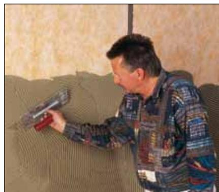
2 ▶ Come collante può essere utilizzato un normale adesivo per piastrelle adatto al supporto, generalmente a presa idraulica. Applicare il collante al sottofondo per la larghezza necessaria utilizzando una spatola dentata (4 x 4 mm).
